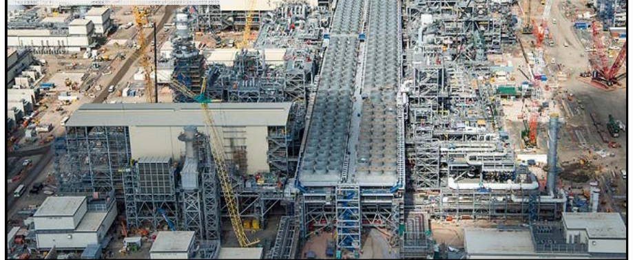
LNGトレインの建設 (2016年9月)
