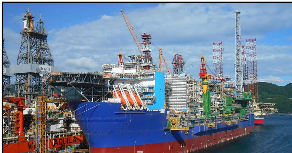
沖合生産・貯油出荷施設(FPSO)建造の様子(2016年9月)
