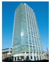
NBFプラチナ タワー (東京都港区)
