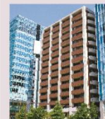
● リエトコート丸の内 (愛知県名古屋市中区)
