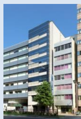
麹町HFビル
