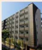
■ セレニテ甲子園 (兵庫県西宮市)
