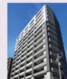
● グランカーサ上前津 (愛知県名古屋市中区)
