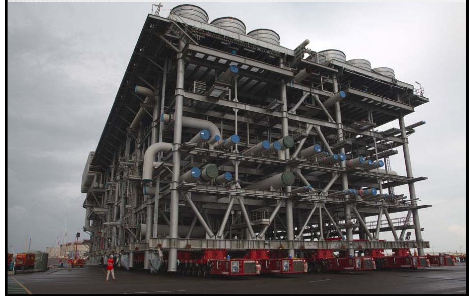
LNGプラント用モジュールの搬入 (2015年1月、ダーウィンにて)
