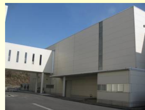
高萩工場第3製剤棟内に設置
