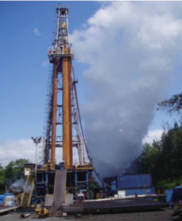
地熱井の仮噴気試験（帝石削井工業株）
