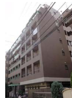
UGH武蔵小杉 マンション
